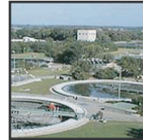
sklárky čistírny odp.vod bioplyn.zařízení
