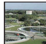
Skládky čistírny odpadních voda
